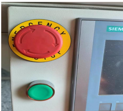
图 3-3 整流模块进线回路接通按钮
