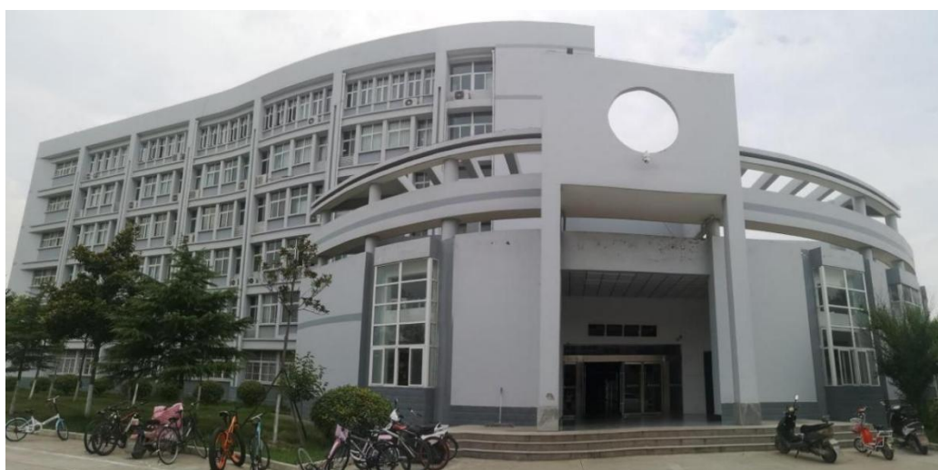
图 2 工科楼 A 入口
