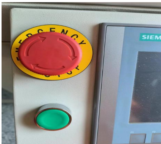
图 4-3 整流模块进线回路接通按钮
