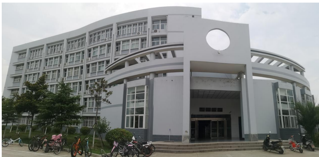
图 2 工科楼 A 入口
