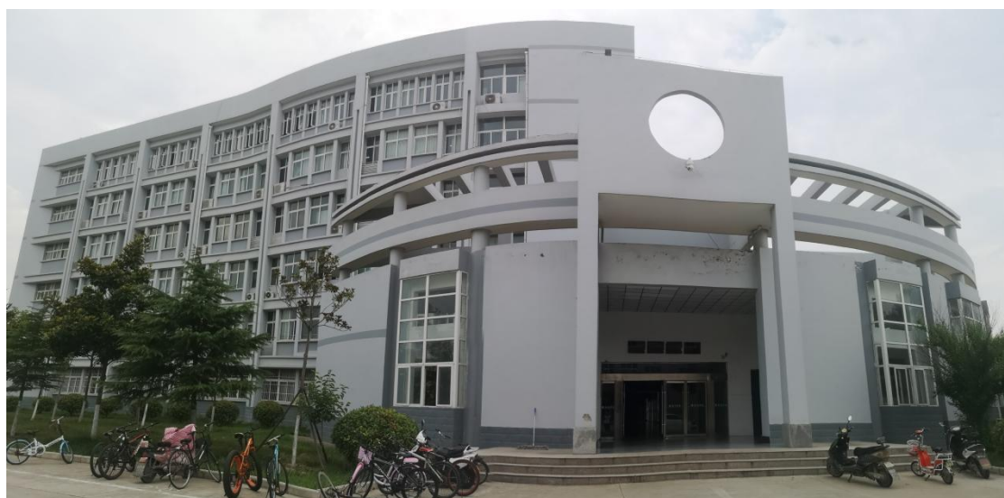
图2 工科楼A入口
