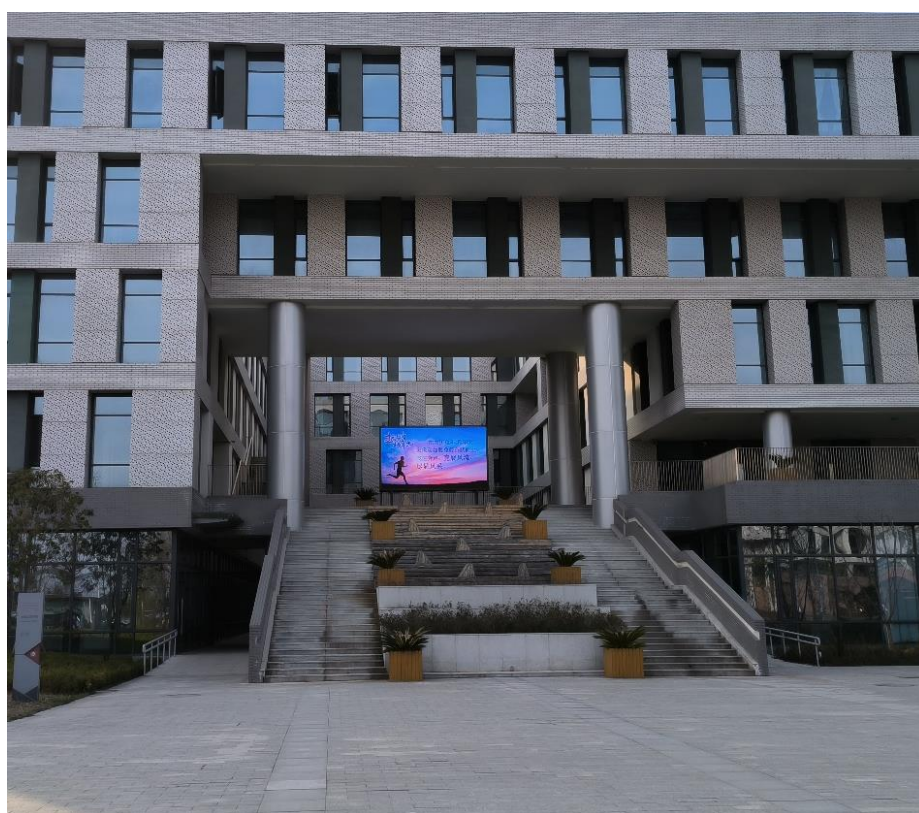
图 2 机械工程学院实训楼 3-1-308 东入口
