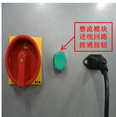
图 4-3 整流模块进线回路接通按钮
