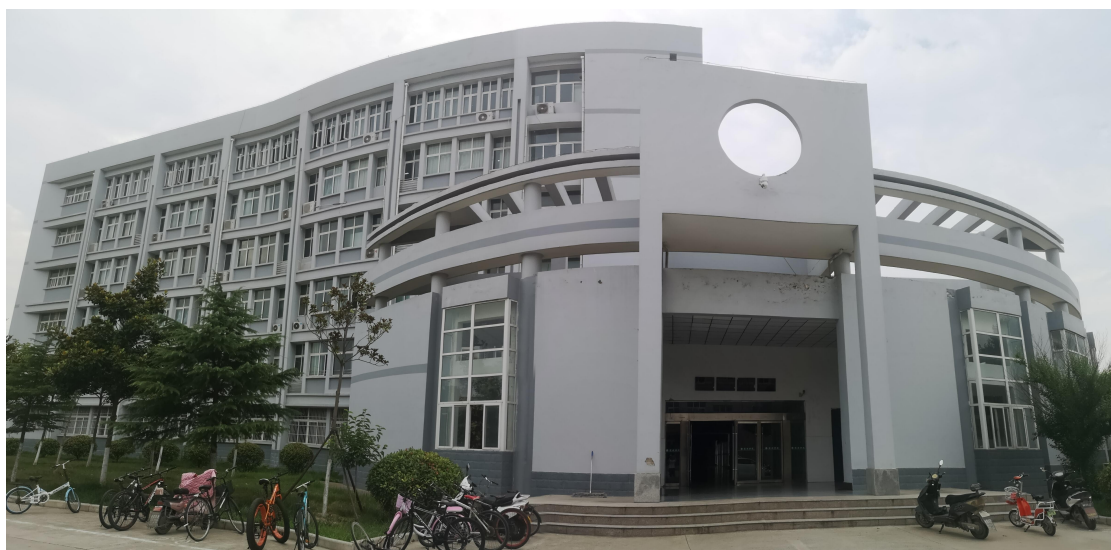
图 2 工科楼 A 入口
