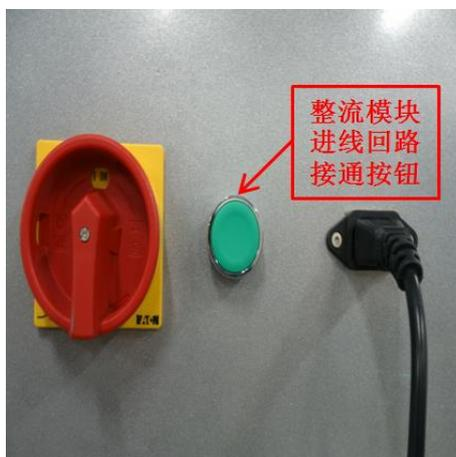
图 4-3 整流模块进线回路接通按钮
